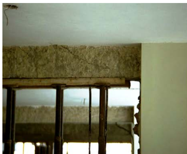
Daños en vigas y losas (Steinbrugge, 1967)
