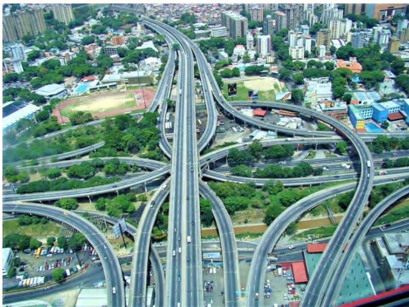
Vista aérea del Distribuidor “La Araña”.
