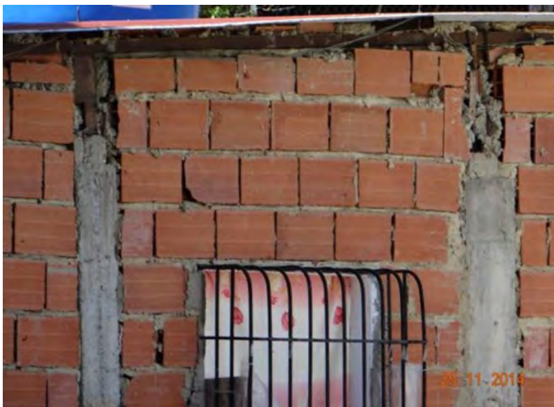
Figura 18.2 Detalles indicativos de deficiencias constructivas de la vivienda.
