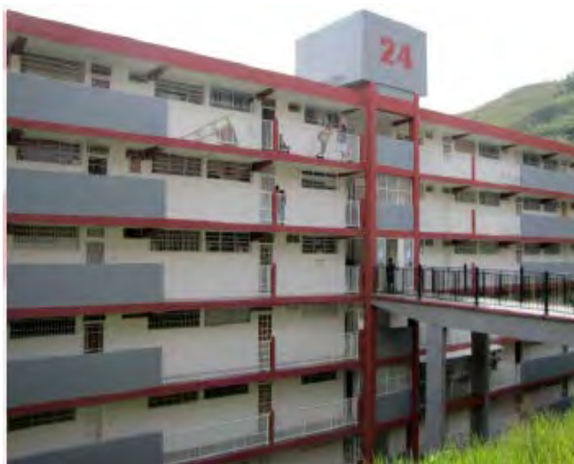
Foto de fachada posterior de la edificación, modelo 6M8.
