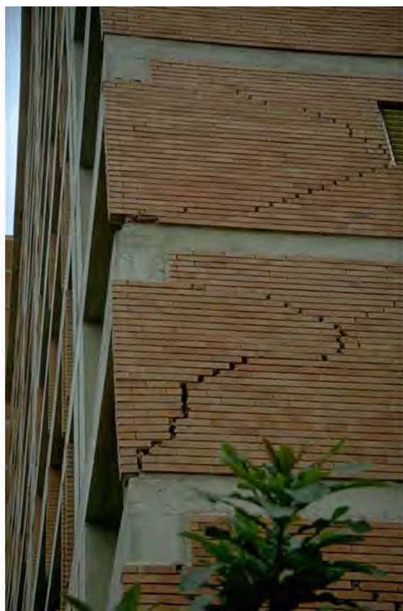
Figura 7.10 Edificio Petunia I. Izquierda: representación de daños en paredes transversales (adaptado de Arcia & Malaver, 1974); derecha: daños en paredes de fachada (Steinbrugge, 1967)
