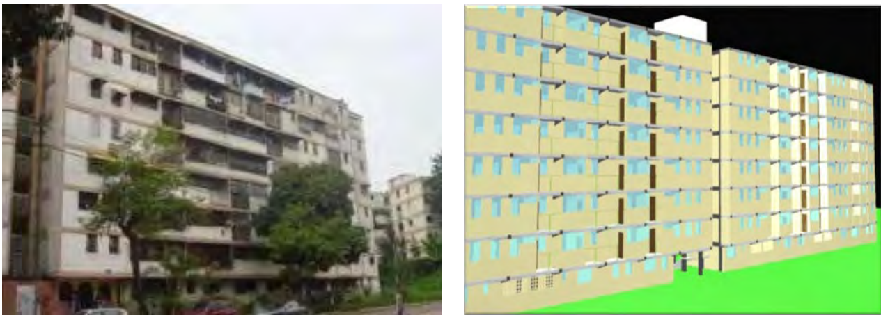
Figura 8.5 Fachada principal e imagen de la animación 3D del edificio tipo 6M8-66. Fuente: Castillo y Villamizar, 2012.
