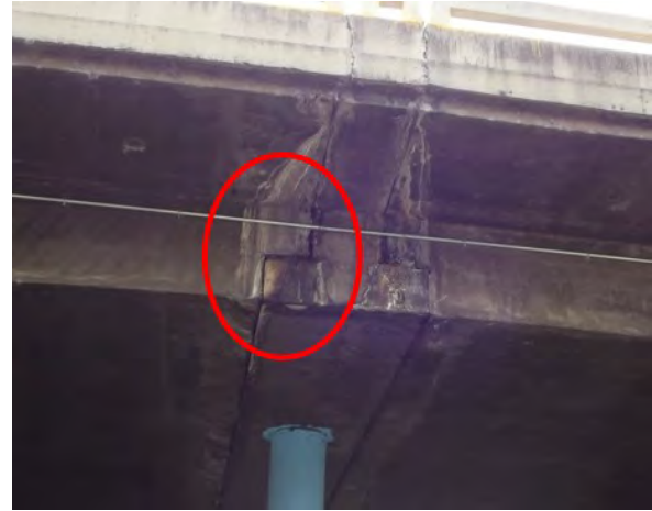
Figura 14.6 Fotografías del Puente Tramo Elevado UCV (el círculo destaca la junta de expansión).
