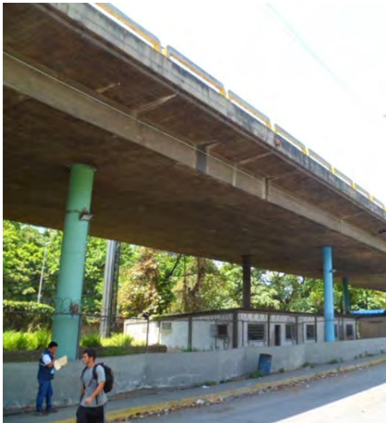
Figura 22.1 Puente Tramo Elevado Valle-Coche, vista general y vista de los apoyos del tablero sobre una pila. Ver Capítulo 14.
