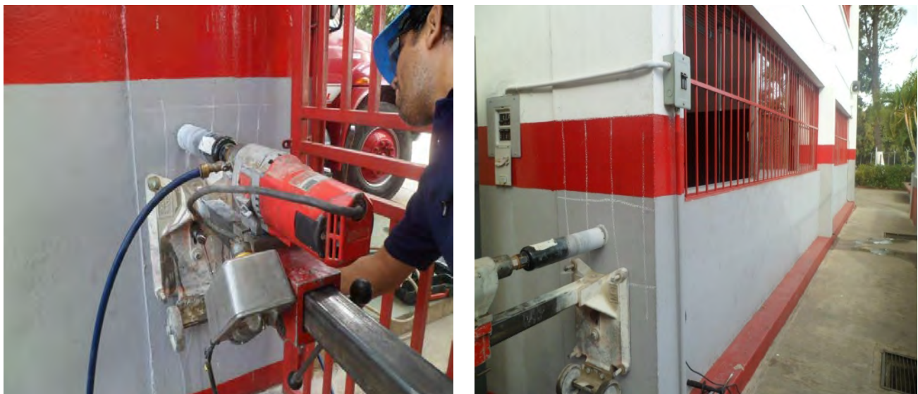
Figura 13.8. Toma de núcleos de concreto en dos columnas de la estructura, a la izquierda en el módulo de doble altura y a la derecha en el de servicios.
