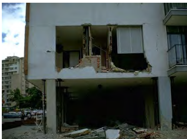
Caída de paredes enteras hacia áreas exteriores del edificio Izq. (Steinbrugge, 1967). Der. (Milek, 1967)
