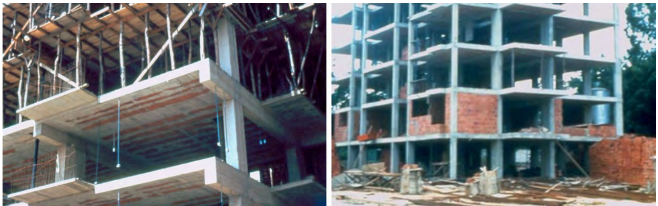
Edificios típicos en construcción en 1967. Fintel et al. (1967) Figura 7.3
