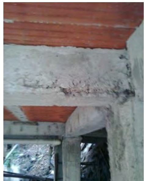
Figura 18.2 Detalles indicativos de deficiencias constructivas de la vivienda.
